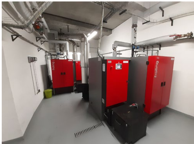
Le due caldaie Fröling Turbomat 250 kW in cascata
