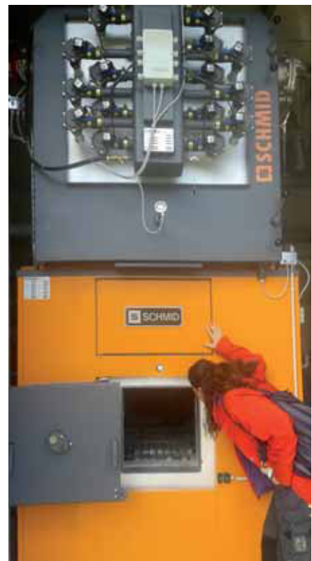
Caldaia a cippato a griglia mobile da 700 kW
