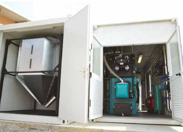
L'impianto all'interno dei container: a sinistra il deposito del pellet, a destra la caldaia e la parte impiantistica
