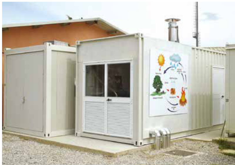
L'impianto all'interno dei container: a sinistra il deposito del pellet, a destra la caldaia e la parte impiantistica
