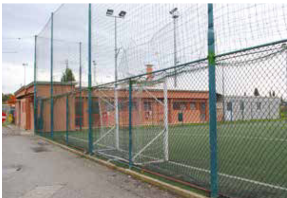
Gli ambienti riscaldati e riforniti di acqua calda sanitaria dall'impianto di SOS Energy. Partendo dall'alto: la scuola, la palestra e il campo sportivo.
