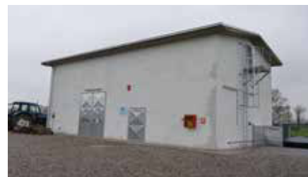
Il nuovo edificio adibito a centrale termica con annesso deposito del cippato da 100 m 3 di capacità di stoccaggio
