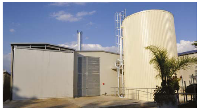
La centrale termica
