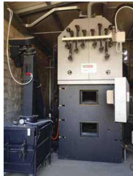
La Caldaia Pyroflex FSB Viessman da 1.100 kW
