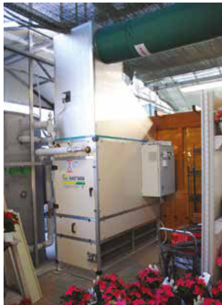
A sinistra, l'impianto ad aria calda collegato all'accumulo inerziale situato all'interno del locale caldaia. Sopra, l'interno del punto vendita
