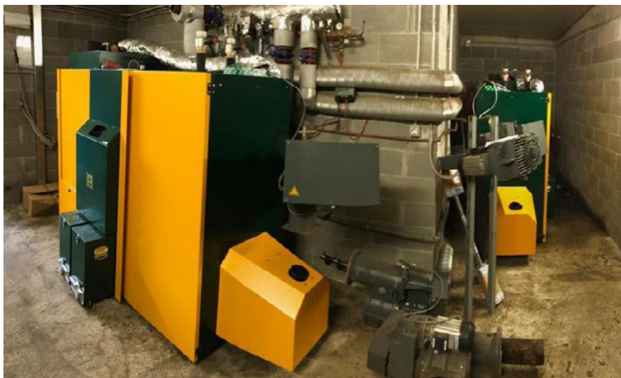
Le due caldaie KWB PelletFire plus modello MF2 S
