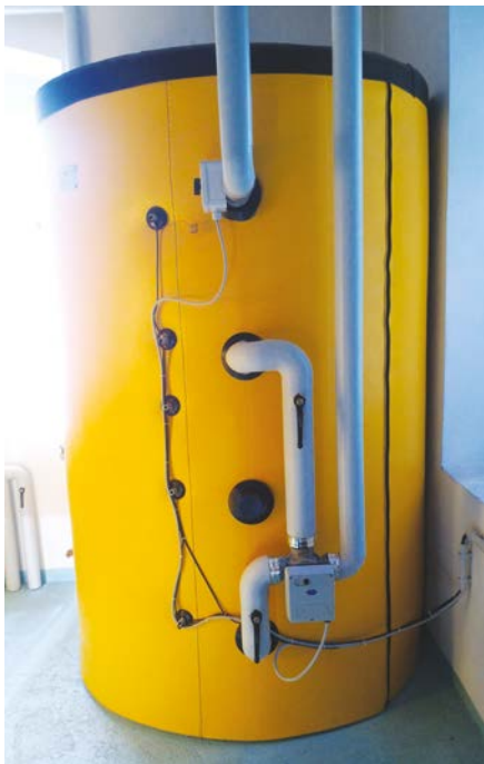
La KWB Combifire 28 con il puffer da 2.000 litri
