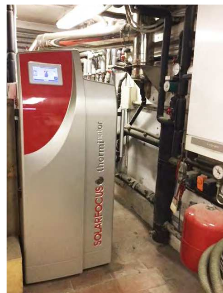
L'innovativa Therminator II° Touch da 40 kW a legna a fiamma inversa di Solarfocus con il corpo caldaia interamente in acciaio inox
