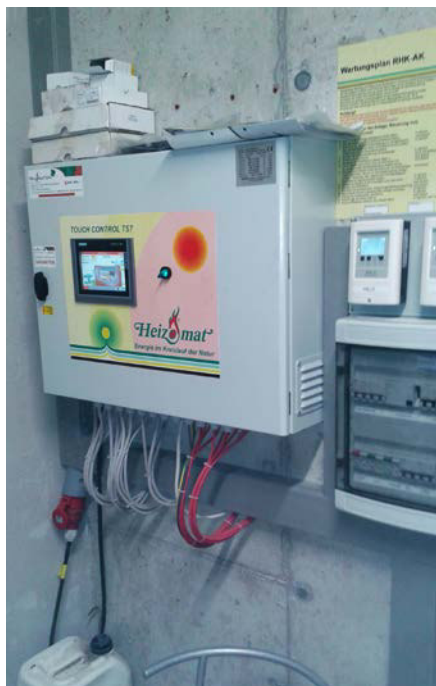
Dettaglio della centralina di controllo della caldaia
