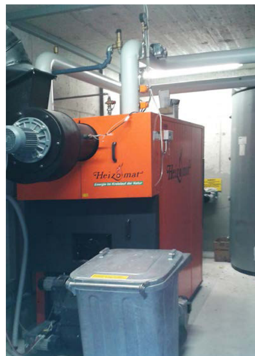
La caldaia RHK-AK 150 installata presso il nuovo capannone dell'Officina Frei
