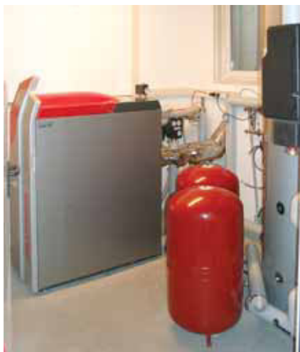
A sinistra: la Solarfocus Pellettop da 25 kW installata presso l'abitazione della famiglia Kemenater. A destra: il puffer da 1.000 litri abbinato alla Pellettop.
