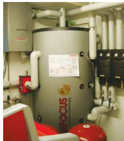
A sinistra: la Solarfocus Pellettop da 25 kW installata presso l'abitazione della famiglia Kemenater. A destra: il puffer da 1.000 litri abbinato alla Pellettop.
